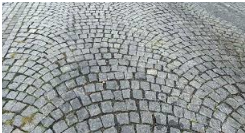
Schéma kladení žulových kostek
