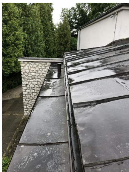
Foto, nefunkční odvodnění
