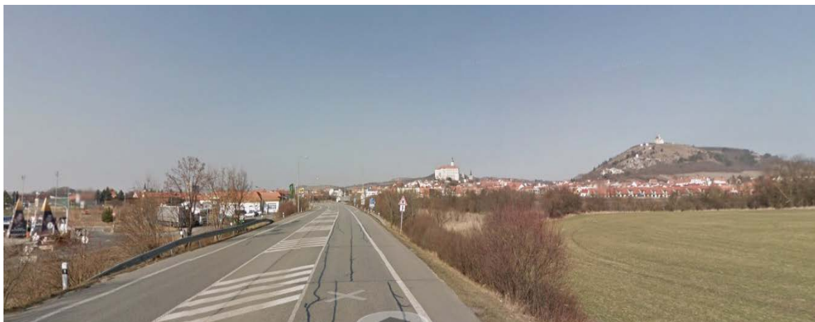
Obr. č.1 - Pohled jižní
